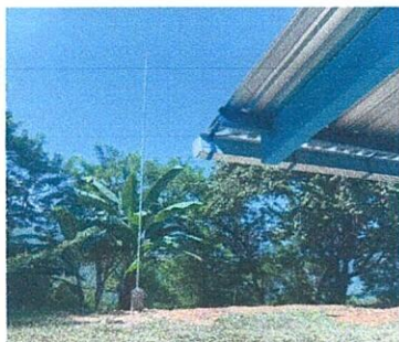
Foto 5: Instalación De Mástil Para Bandera
