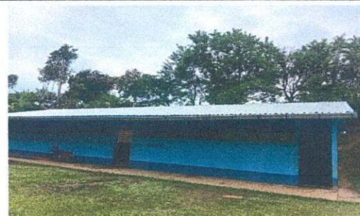
Foto 6: INSTALACIÓN COMPLETA DE LAMINAS TROQUELADA CALIBRE 26
