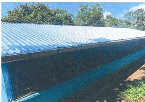
Foto 3: SUSTITUCIÓN DE CUBIERTO DE LAMINA TROQUELADA CALIBRE 26 EN MODULOS
