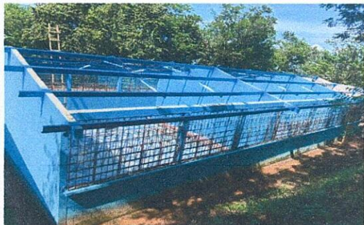
Foto 1: PINTADO DE COSTANERAS METÁLICAS
